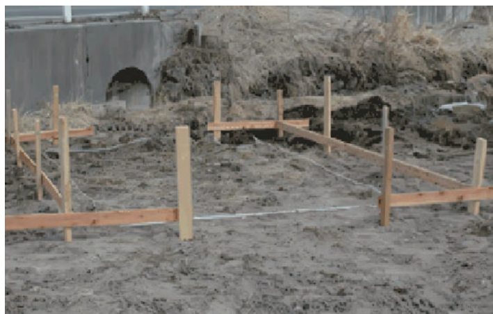
貫板が打ち終わった状態
