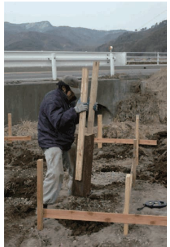
碎石の突き固め
